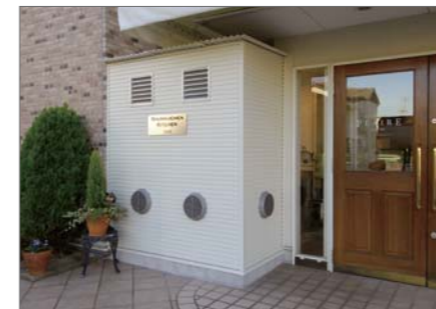
新設バームキッチン
